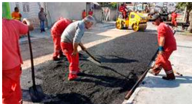
Figura 06: Execução de Trecho com ARC. Espalhamento do material asfáltico.
