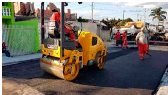
Figura 07: Execução de Trecho com ARC. Compactação do asfalto e finalização dos serviços.
