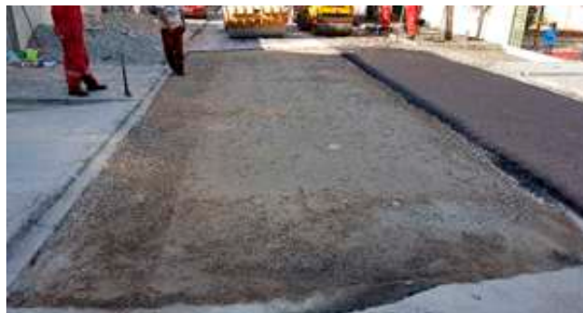
Figura 04: Execução de Trecho com ARC. Trecho após compactação.
