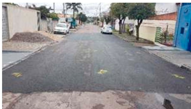
Figura 08: Trechos após a execução .
