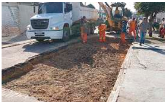
Figura 02: Execução de Trecho com ARC. Remoção do pavimento danificado.
