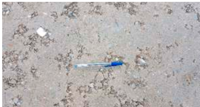
Figura 05: Execução de Trecho com ARC. Aspecto do pavimento compactado.
