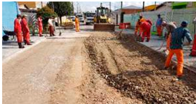
Figura 03: Execução de Trecho com ARC. Espalhamento do agregado reciclado de concreto.
